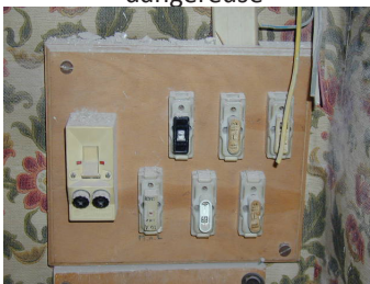
Installation électrique dangereuse
